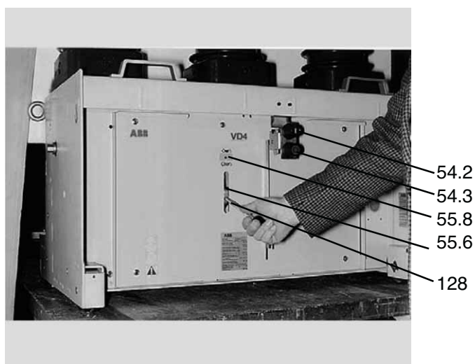
图6/7 固定式VD4，反复操作手动储能手柄对弹簧操动机构进行储能
